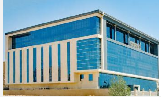
مبنى النيابة العامة
