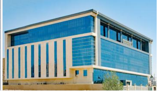
مبنى النيابة العامة
