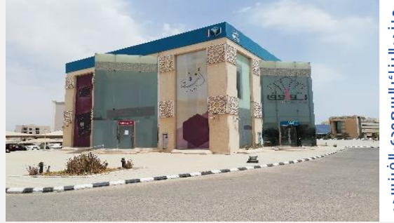
مبنى البنك السعودي الفرنسي
